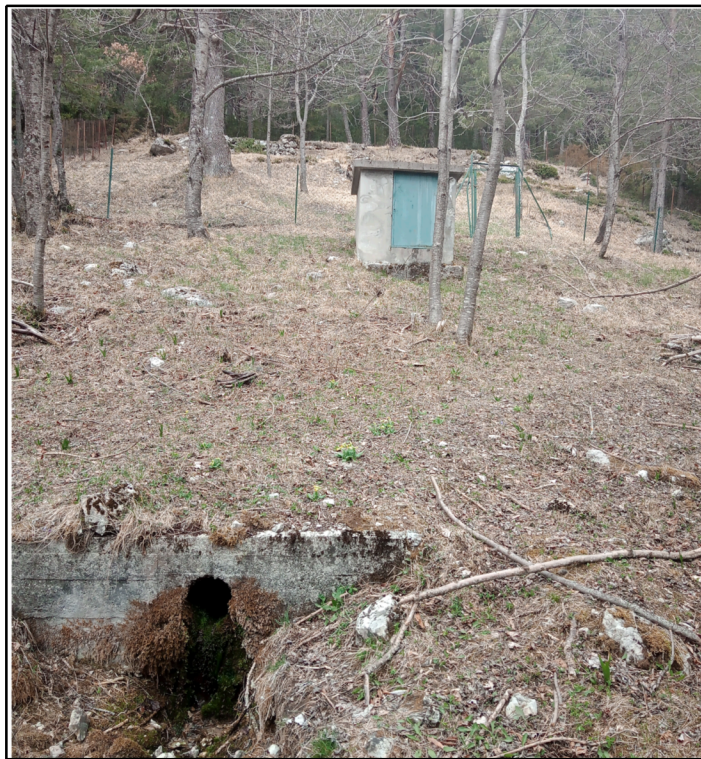
Photo ouvrage source Saint Barbabé 11/04/2022
